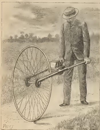
Fig. 1. - Odógrafo movido por un viandante
